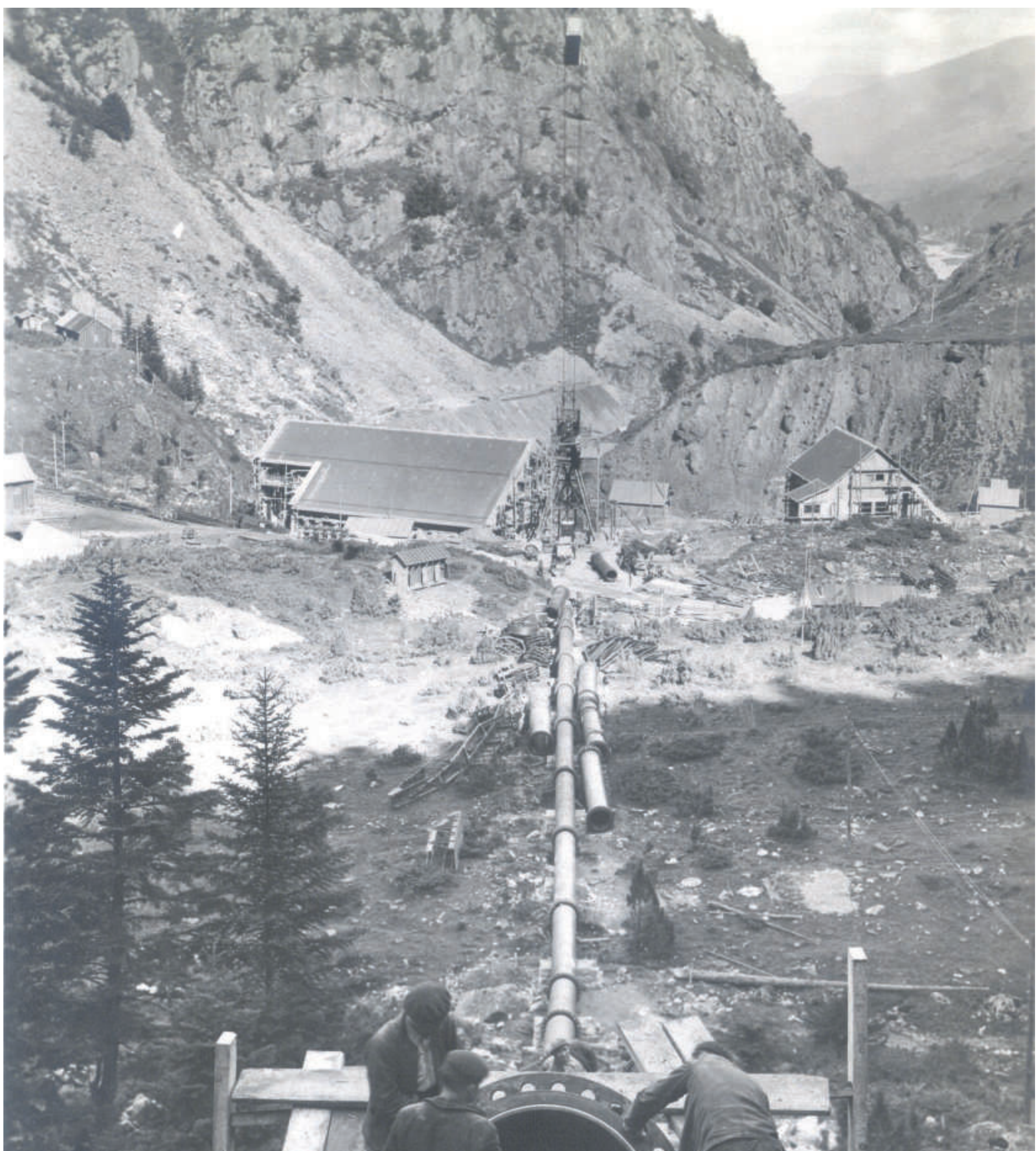
▲ Montage des conduites forcées pour la centrale hydroélectrique de Pont de Prat en 1930 – archives SHEM
