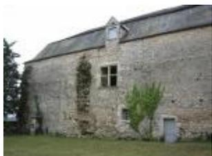
**Le château de la Pannonie : traces des arrachements de murs de l'aile nord disparue, sur la façade sur cour de l'aile est**
